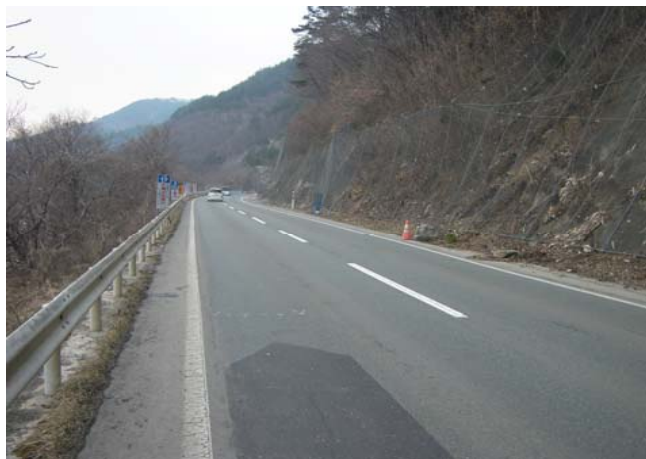
落石発生箇所全景
