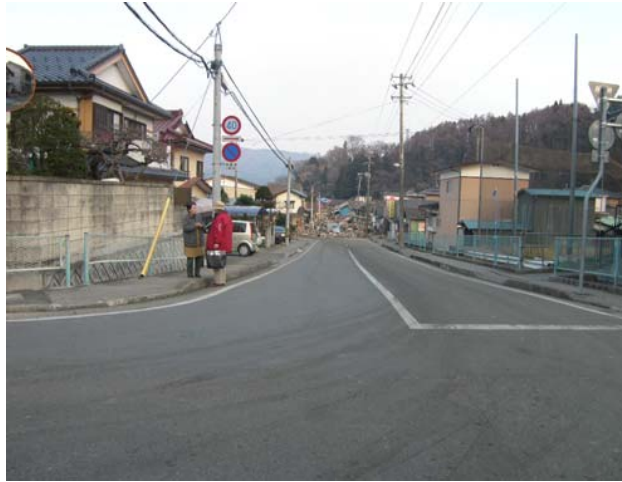
大船渡市内③箇所 被災状況
