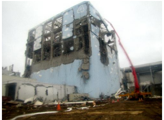
△福島第一原発4号機の現状 外壁がぼろぼろに壊れている
