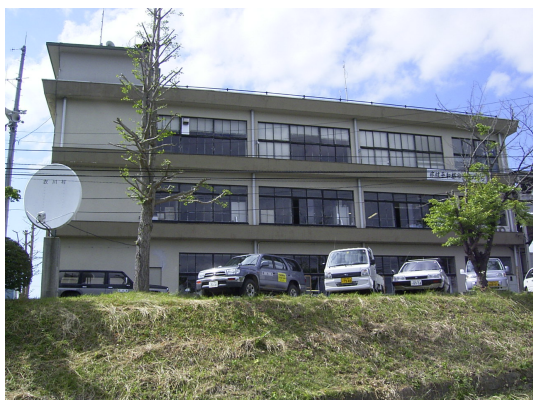
写真-1 南東側から見た衣川支所
