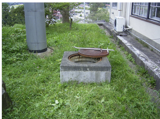
写真-3 震度計周辺の状況
