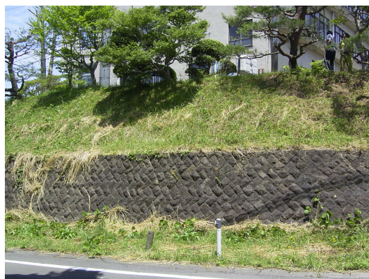
写真-2 南西側から見た衣川支所
