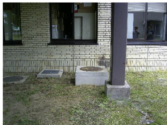
写真-2 震度計センサを設置しているコンクリート升
