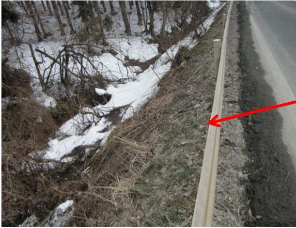
盛土法面状況
