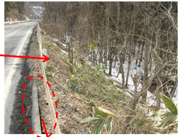
盛土法面状況
