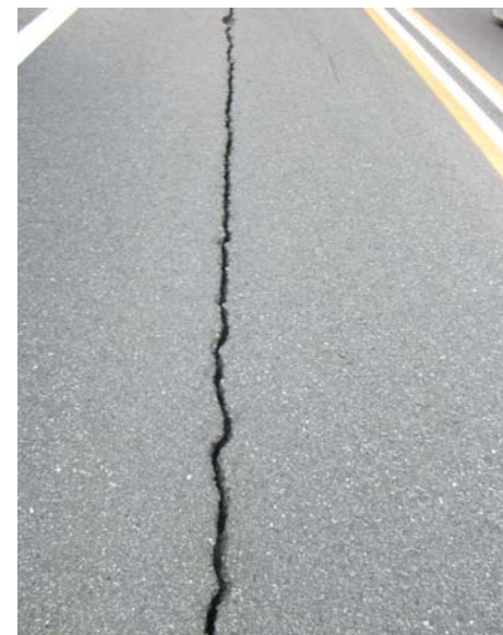
段差・亀裂発生状況(②箇所)
