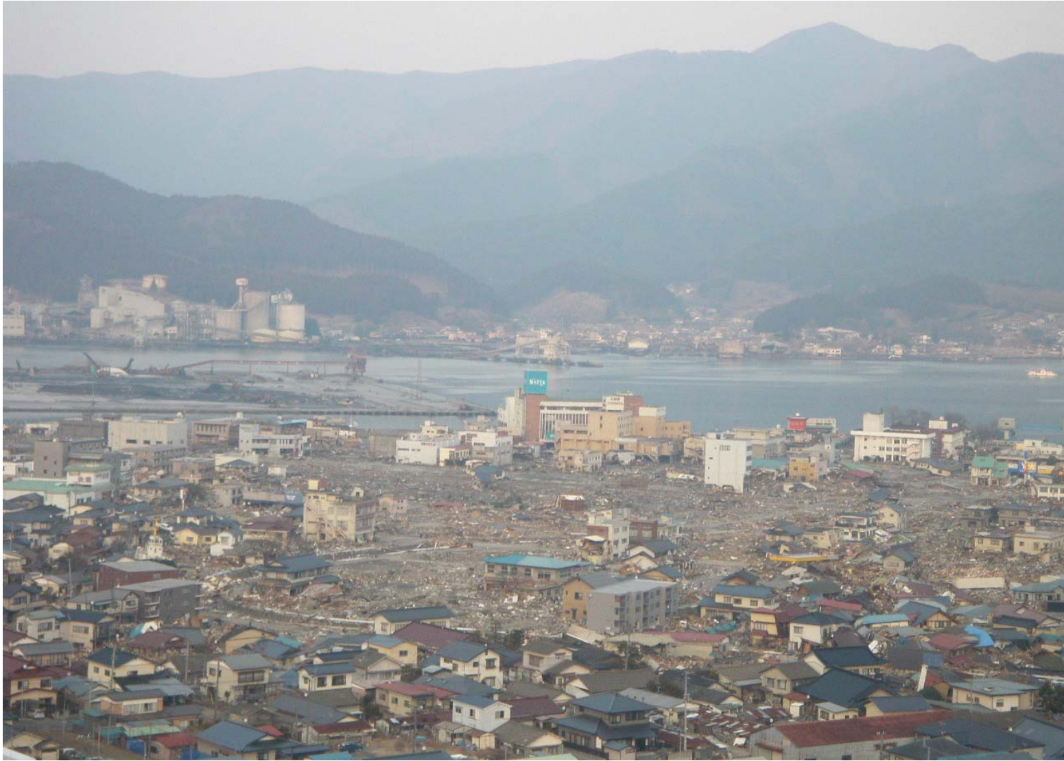
大船渡市内被災状況（大船渡三陸道路より撮影）
