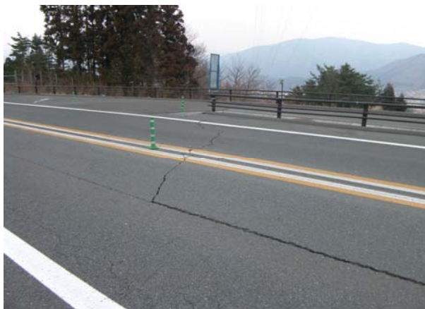
段差・亀裂発生状況(②箇所)
