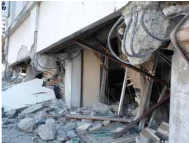
写真-2(2)② 市役所傍の飲食店IFのRC柱せん断破壊
