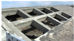
二川目海岸護岸5..JPG
