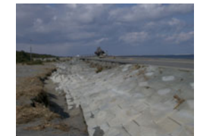
二川目海岸護岸2.JPG
