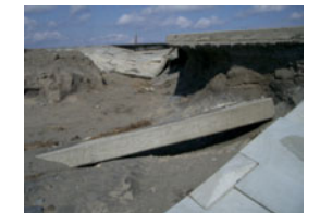
二川目海岸護岸1.JPG
