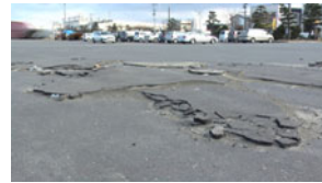
八戸漁港館鼻岸壁4.JPG
