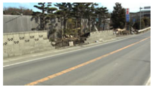
三川目ブロック塀..JPG
