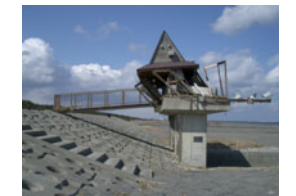
二川目海岸監視小屋.JPG
