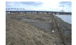
馬淵川左岸3.4k水辺の楽校 土砂堆積.JPG
