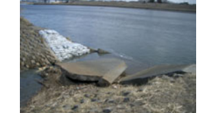
馬淵川左岸2.4k樋管合流 部.JPG
