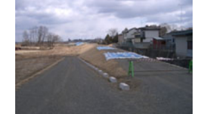
馬淵川右岸5.2k天端.JPG
