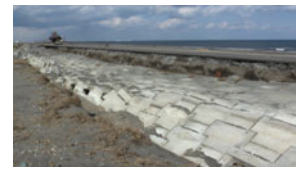
二川目海岸護岸4..JPG
