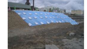
馬淵川左岸0.0k川表法 面.JPG
