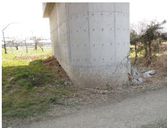
写真 20 コンクリートの剥落は橋台側（写真右側）に集中しているのが分かる。
