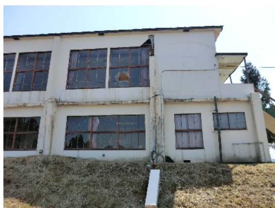
写真29 衣川体育館の外壁。柱型が地震により剥落している。
