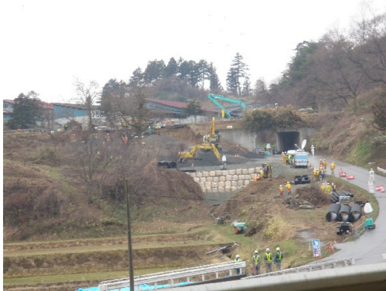
写真21 東北自動車道前沢平泉インター付近ののり面の崩壊。北緯39度02分39秒，東経141度07分00秒
