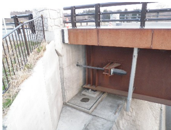
写真11 新大久保橋。落橋防止装置と沓
