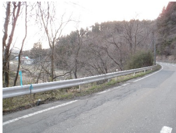
写真 8 路面に見られるクラック。北緯 38 度 54 分 41 秒，東経 141 度 04 分 02 秒
