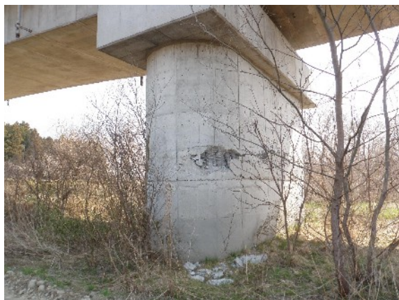
写真 18 江崎大橋の被害状況。北緯 39 度 13 分 21 秒，東経 141 度 07 分 03 秒。
