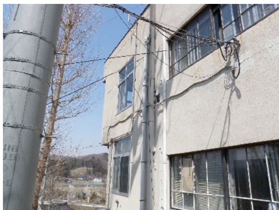
写真27 奥州市衣川総合支所。3階柱脚部分が大きく破損している。
