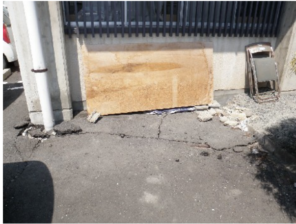
写真 30 江刺総合庁舎に隣接する建物における周辺地盤の変状。北緯 39 度 11 分 31 秒，東経 141 度 10 分 31 秒
