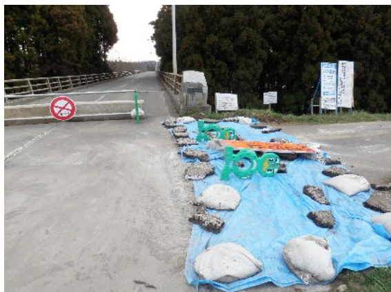
写真17 国見橋東詰。北緯39度15分11秒，東経141度06分47秒
