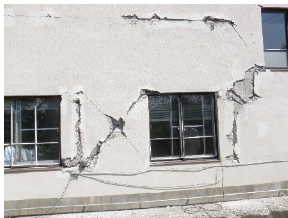
写真28 奥州市衣川総合支所。1階壁部の破損。
