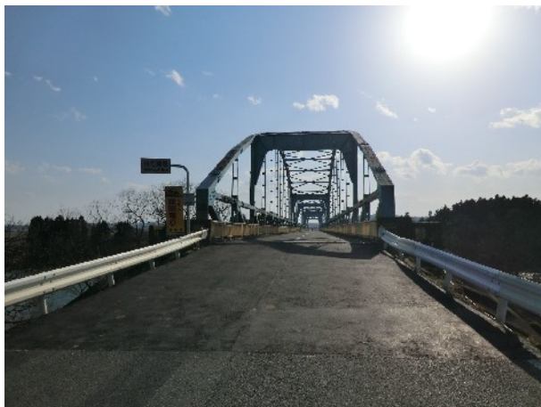
写真3 東側（北緯 38 度 57 分 22 秒，東経 141 度 09 分 37 秒）から撮った棚の瀬橋。
