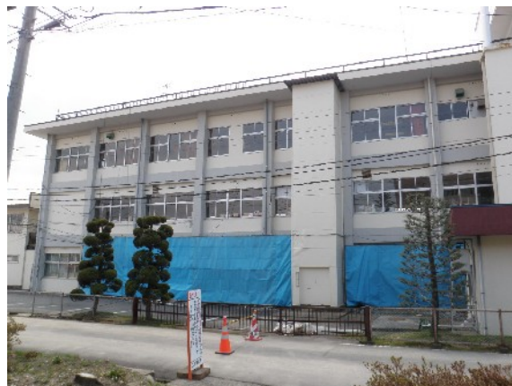
写真25 総合支所南側の建物(JA?)の北面の被害状況。北緯39度03分03秒，東経141度07分28秒
