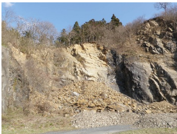
図 2 薄衣城跡の崖崩れ．北緯 38 度 53 分 33 秒，東経 141 度 15 分 58 秒
