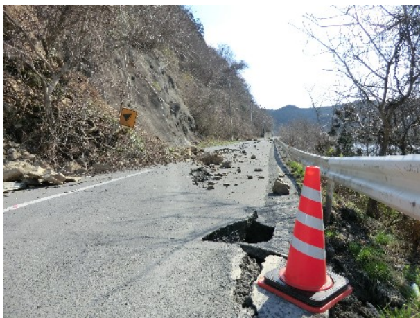
写真1 県道 189 号線で見られた道路被害．右側が北上側．北緯 38 度 51 分 20 秒，東経 141 度 15 分 34 秒．
