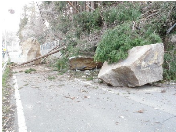
写真 6 岩塊の落下により閉鎖された国道 457 号線。北緯 38 度 54 分 40 秒，東経 141 度 03 分 54 秒。
