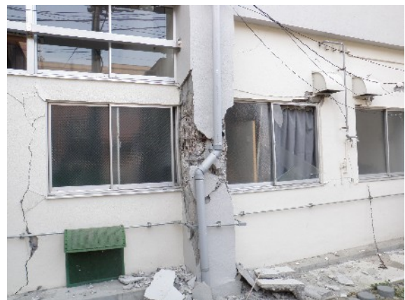
写真26 柱の被害。左の写真の右側を撮ったもの。
