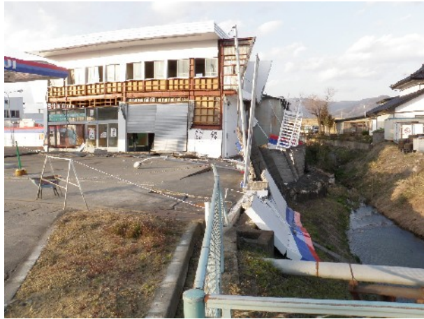
写真32 小河川側に地盤が滑ったために被災をうけた事務所建物。北緯38度57分55秒，東経141度07分25秒
