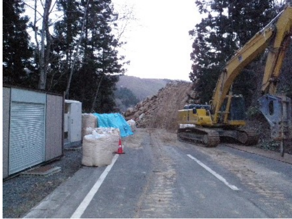
写真 12 国道 342 号線道路閉鎖地点。北緯 38 度 58 分 21 秒，東経 140 度 58 分 54 秒
