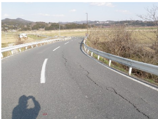
写真4 棚の瀬橋のアクセス道路に見られた縦クラック。北緯 38 度 57 分 23 秒，東経 141 度 09 分 44 秒
