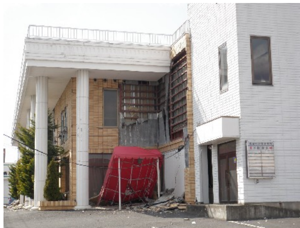
写真 31 一関 IC 近くで見られた建築物の被害。北緯 38 度 56 分 20 秒，東経 141 度 06 分 18 秒
