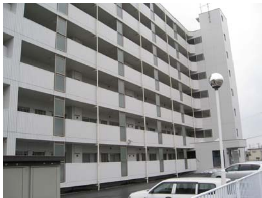
写真 22 岩切中学校観測点（計測震度 6.4）の付近のマンションの被害（外観と異なり，壁，柱にひび割れ多く，ドアの開閉が不能に）
