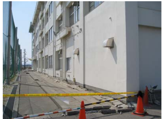
写真 29 七郷中学校（計測震度 6.5）の校舎の被害
