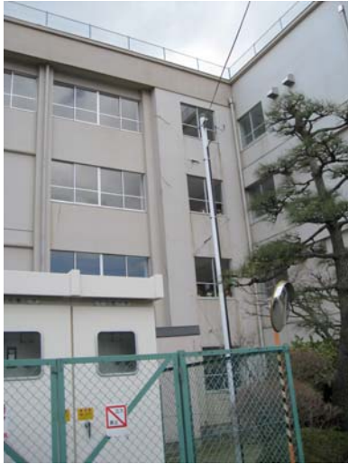
写真 14 七北田中学校校舎の被害状況 （壁にせん断破壊のひび割れが多く認められ、当面使用不能、授業は別な学校で）
