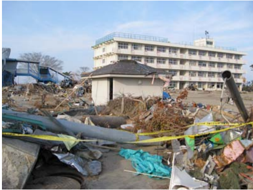
写真7 荒浜小学校近辺の被災状況
