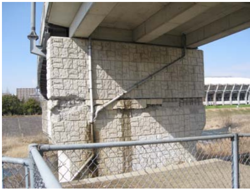
写真 16 仙台地下鉄南北線の七北田川橋梁の 被害（七北田中学校に近い）。その他、南北 線の高架橋橋脚にはせん断ひび割れが多い）
