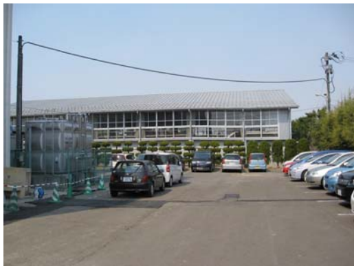
写真 24 南光台東小学校（Small-Titan 観測点）の体育館の被害，柱の座屈が顕著であり，危険建物として体育館は立ち入り禁止
