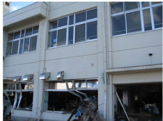
写真9 荒浜小学校1階、2階の被災差
