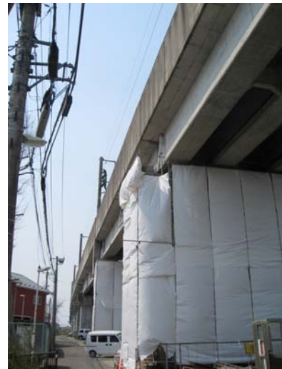
写真 23 岩切駅付近の東北新幹線の高架橋の被害（橋脚の被災と架線の被害が岩切地区で著しい）
