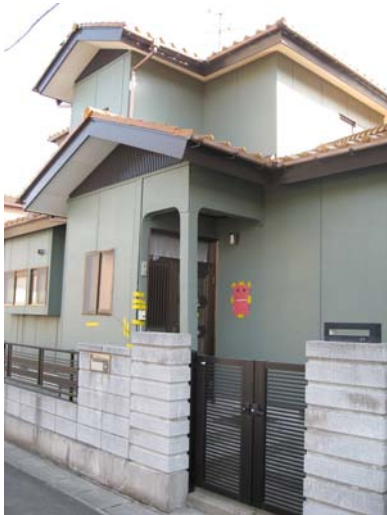
写真 28 七郷中学校（計測震度 6.5）の近辺民家の被害（新築に近いが立ち入り禁止で危険の赤紙がみえる）
