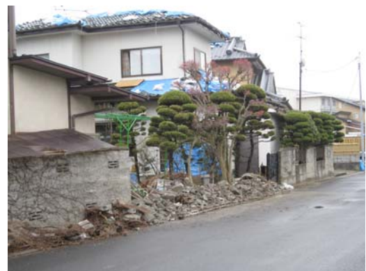
写真 19 岩切中学校観測点（計測震度 6.4） の付近の民家の被害（立ち入り禁止の民家が 多い）
