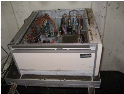
写真 12 荒浜観測ステーション内部 (MPU の覆い蓋を開いて中の基盤の状況を確認。完全に水没しており, 機能回復は困難と判断される状況)
