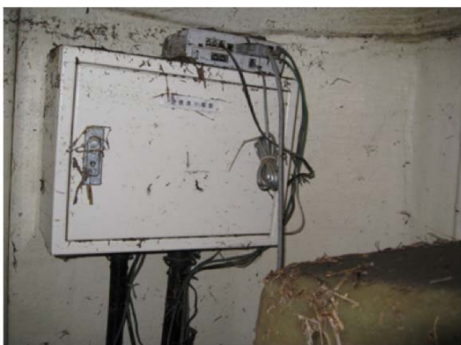
写真10 荒浜観測ステーション内部 (電源盤と通信設備で完全に水没した形跡を示している。手前にMPUを保護する覆いカバーがみえる)
