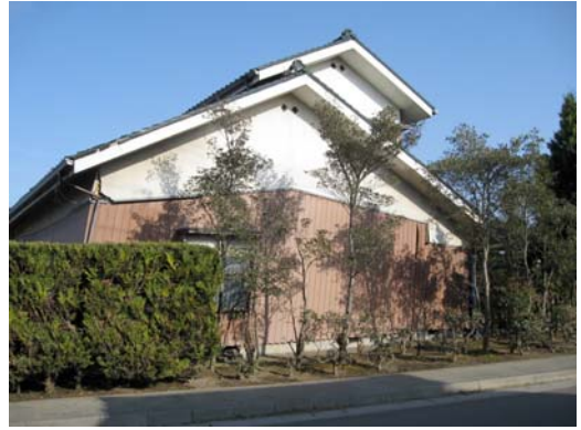
写真 27 七郷中学校（計測震度 6.5）の近辺民家の被害（転倒寸前で立ち入り禁止）
