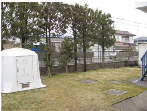
写真 18 岩切中学校観測点（計測震度 6.4） の観測小屋と付近の民家の被害（木の向こう 側の民家は軒並み被害）
