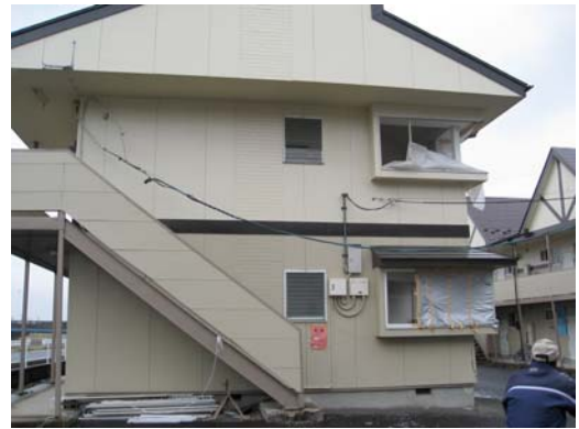
写真 21 岩切中学校観測点（計測震度 6.4）の付近のアパートの被害（立ち入り禁止）
