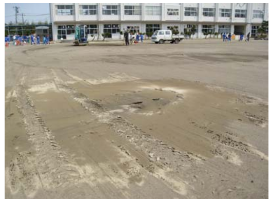
写真 25 南光台東小学校（Small-Titan 観測点）の校庭被害（全面的に液状化）。その他，南光台地区はライフラインの被害顕著。
