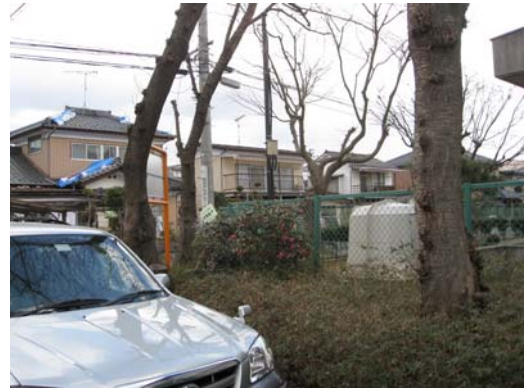
写真 15 七北田中学校観測点（約 1800 ガル） の観測小屋と付近の民家の被害
