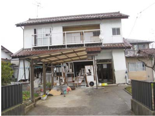
写真 20 岩切中学校観測点（計測震度 6.4）の付近の民家の被害（立ち入り禁止の民家）
