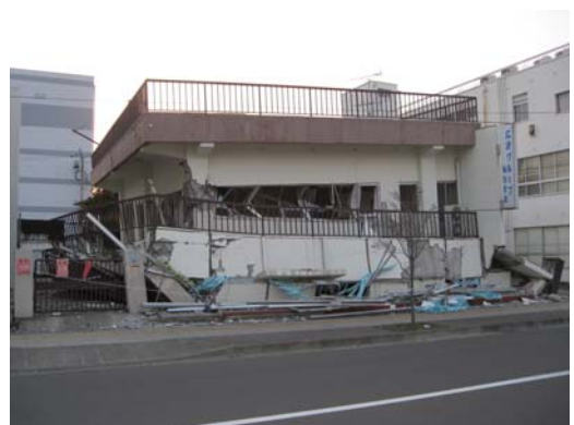
写真 31 卸町地区の建物被害
