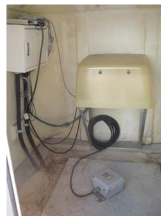
写真 5 観測ステーションの内部状況
