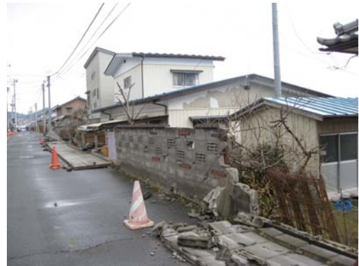
写真 17 仙台市松森地区（七北田から岩切へ 至る地区）の被害状況、被災民家が多い。近 くの仙台市松森清掃工場も被災。
